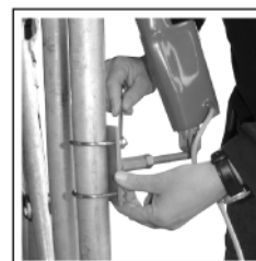
Pose du vérin à l'aide de la bride inférieure.
